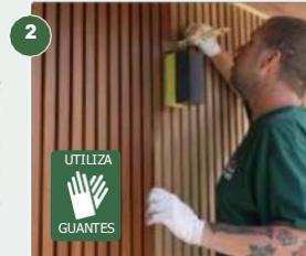
Aplica una capa generosa de DuroGrit y distribúyela de manera uniforme sobre la superficie con una brocha híbrida (mezcla de cerdas naturales y sintéticas).
